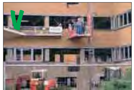
Gondelsysteem dat verticale verplaatsing van lasten en personen mogelijk maakt
