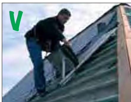
Klein wagentje om dakpannen en dakleien te verplaatsen op een hellend dak
