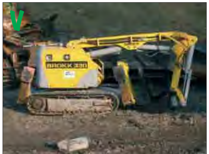
Robot bij asbestverwijdering van windverhitters
