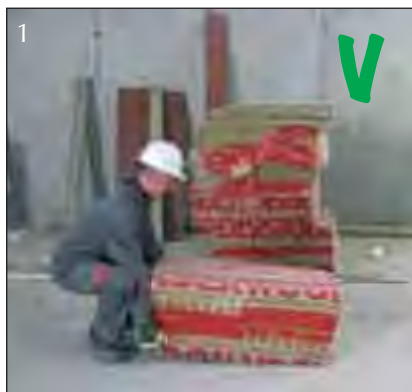
Rechtzetten van een pak isolatieplaten
