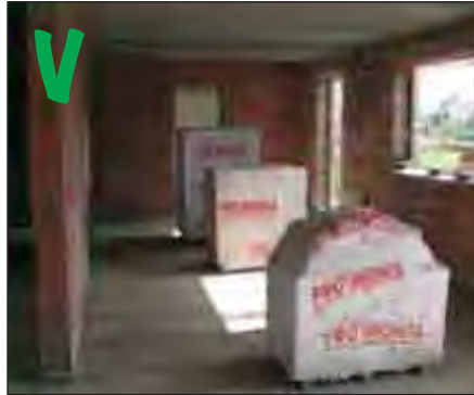
Opslag van pallets met blokken en gipsplaten vóór elke op te trekken muur
