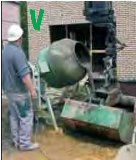
Kraangrijper om de specie naar de verdieping over te brengen
