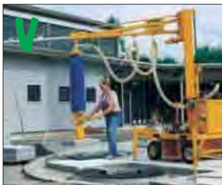
Zwenkarm met vacuümtang om vloertegels te verplaatsen
