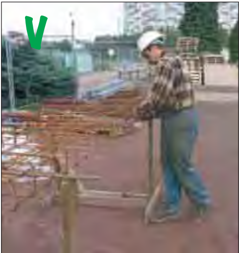
Werkvlak voor het verbinden van metalen stangen
