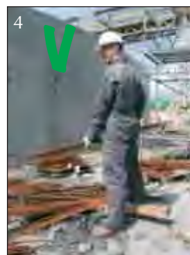
Houdingen bij het overeind zetten van betonijzers
