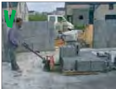
Manuele pallethefwagen (transpallet) om blokken te verplaatsen
