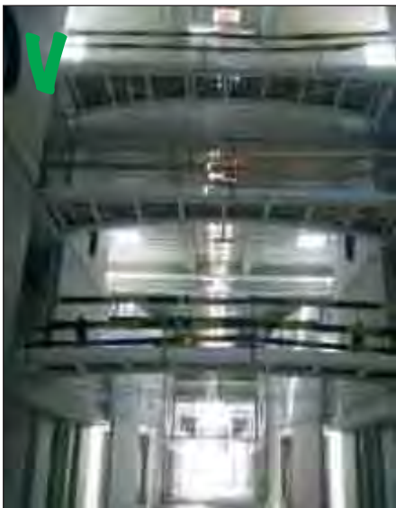
Vroege plaatsing van loopplanken voor een vlotte toegang
