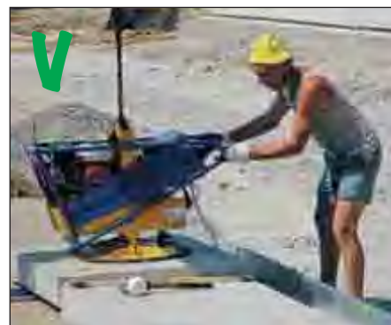
Zwenkarm met vacuümtang om vloertegels te verplaatsen
