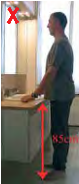
Werkvlak op te lage hoogte: 85 cm voor iemand van 185 cm
