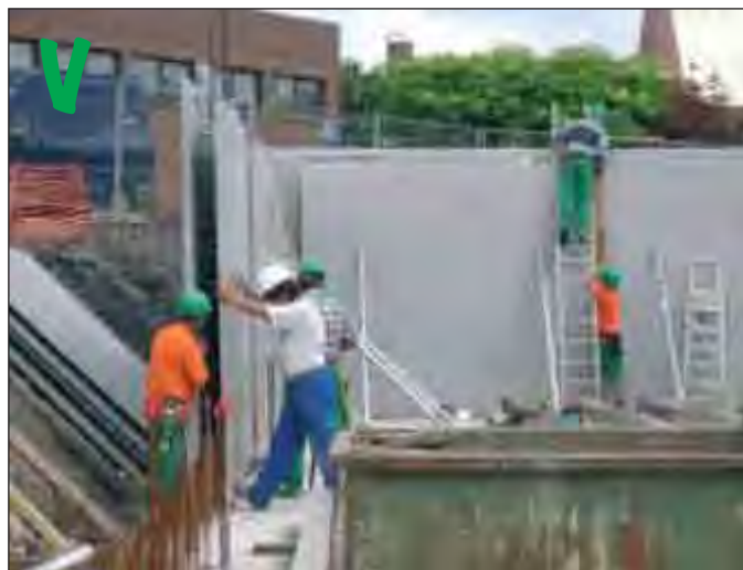
Pre-muren vervangen het metselen van blokken
