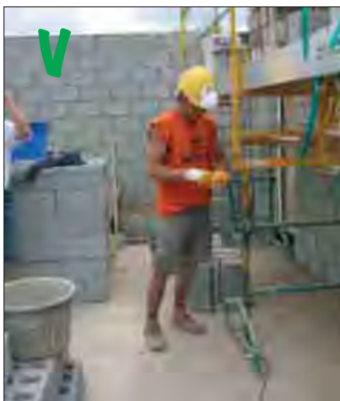
Stelling met twee niveaus, waarvan de hoogte kan worden versteld met een zwengel
