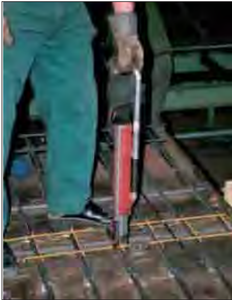
Draadverbinder om oud ijzer samen te binden in rechtopstaande houding
