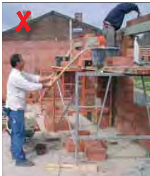
Mortel scheppen uit de kruitwagen die op de begane grond staat, en overbrengen naar de steiger: eentonig werkje
