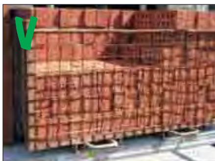
Bakstenen gegroepeerd in bakken of containers die met een kraan of heftruck kunnen worden verplaatst
