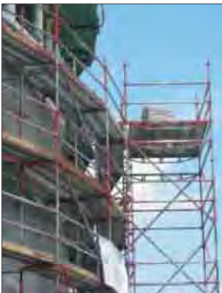
Materiaallosvloer op een steiger om de materialen gemakkelijk te deponeren en over te brengen met de kraan
