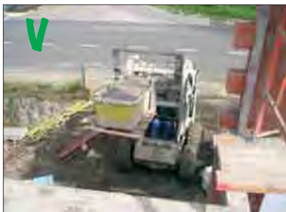
Een heftruck plaatst de kuip op de juiste hoogte op de steiger
