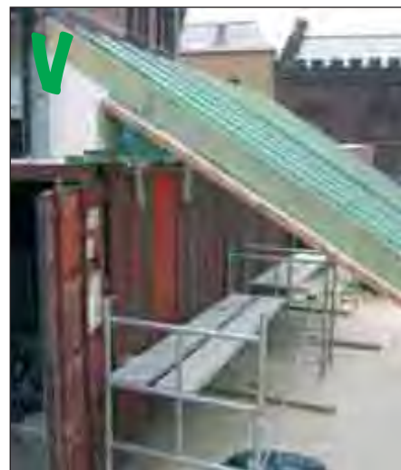
Dakconstructies die vóór de plaatsing in de werkplaats worden geassembleerd
