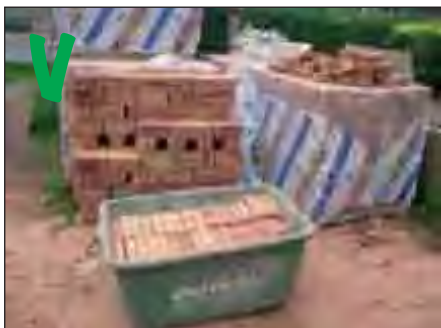
Bakstenen gegroepeerd in bakken of containers die met een kraan of heftruck kunnen worden verplaatst
