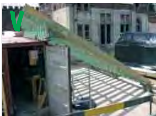
Vervoer van stukken dakgebinte die in de werkplaats zijn geassembleerd
