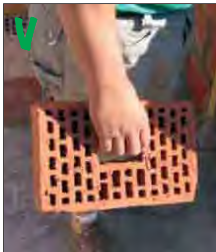
Inkepingen in de blokken voor een gemakkelijker greep
