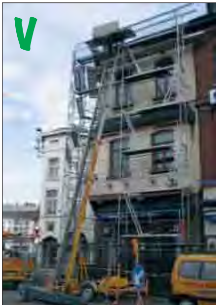
Goederenlift: zo moeten de lasten niet langs de steigers worden ver-
