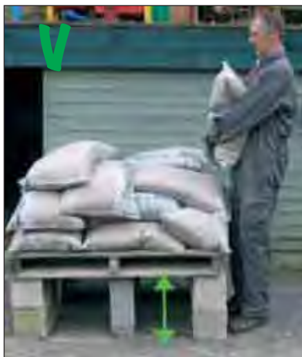
Niet-verstelbare verhogen om zakken zand en cement neer te zetten: beter voor de rug
