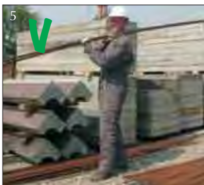
Houdingen bij het overeind zetten van betonijzer
