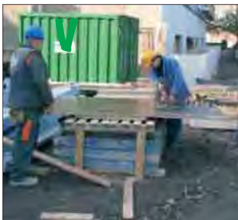
De bekistingsplaten worden gezaagd op een verhoog met aangepaste hoogte in plaats van op de grond
