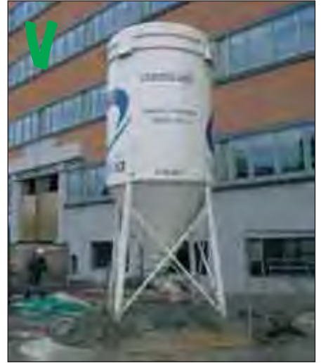
Mengsilo vervangt klassieke betonmolen
