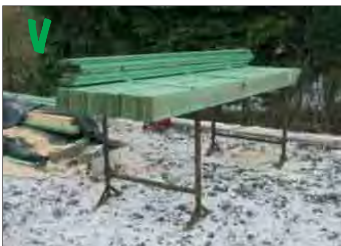
De zware planken worden op schragen gelegd om ze gemakkelijker te kunnen grijpen of verzagen
