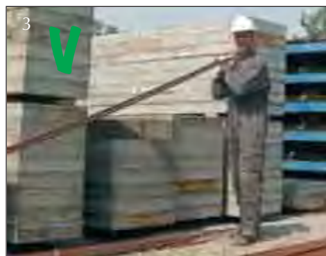
Houdingen bij het overeind zetten van betonijzer
