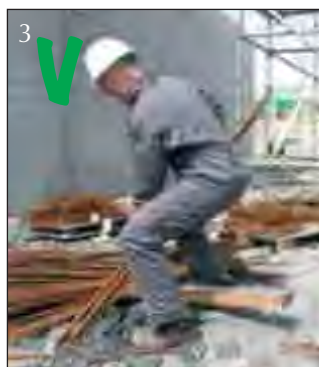
Houdingen bij het overeind zetten van betonijzers
