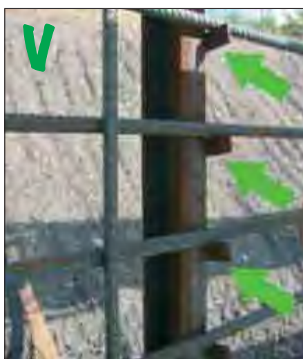
Horizontale steunen op liggers om de betonstaven te ondersteunen
