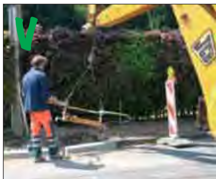
Tang voor trottoirbanden, bevestigd aan bouwplaatsmachine, voor het verplaatsen van zware lasten
