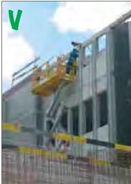
*Plate-forme élévatrice mobile*
