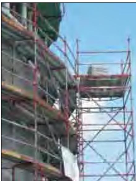
*Recette à matériaux placée sur un échafaudage permettant la dépose et le transfert aisé des matériaux par la grue*
