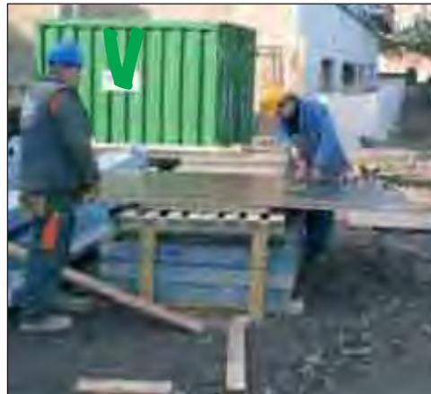
*Utilisation d'un support pour la découpe des plaques de coffrage en hauteur plutôt que sur le sol*
