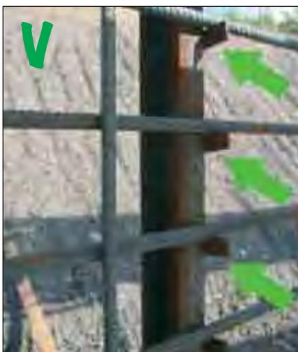
Lors de la confection des parois en béton armé, la mise en place de supports métalliques horizontaux sur les poutrelles pour maintenir les barres à béton pendant la ligature rend cette opération moins pénible
