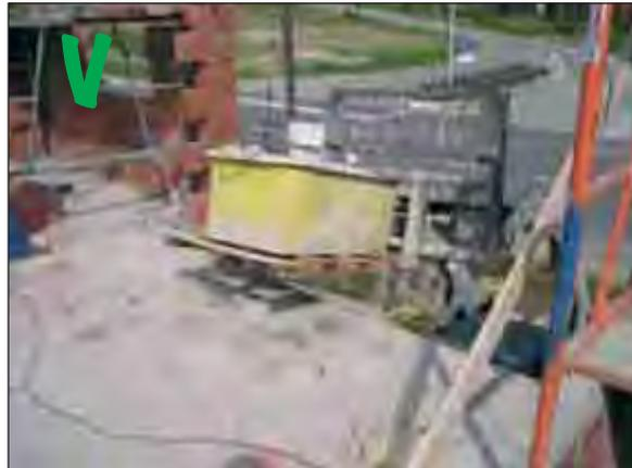
*Mise à hauteur de la cuve sur l'échafaudage par un chariot élévateur*
