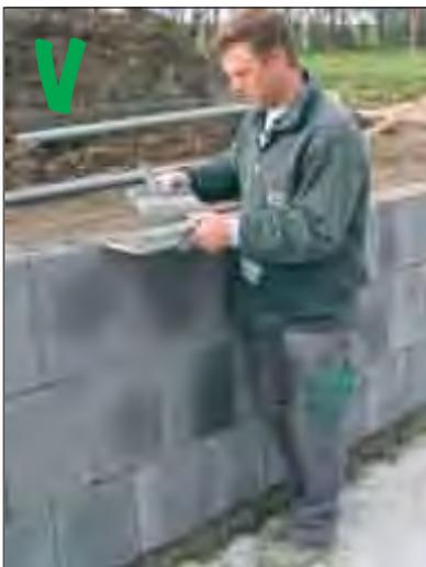
*Mise en place avec une spatule du ciment-colle sur les blocs béton d'argile expansé*
