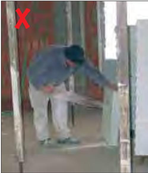
*Découpe de plaques de plâtre sur le support constitué par les plaques en attente plutôt qu'au sol : une façon de pallier l'absence de rehausse*
